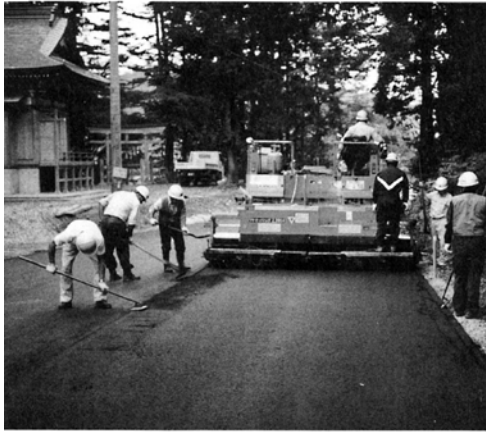
村内での舗装工事
