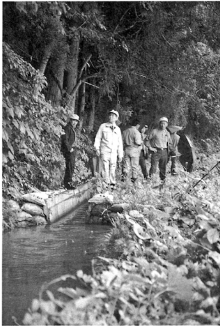
村内視察でも水路改修の要望があった(平良地区にて)
