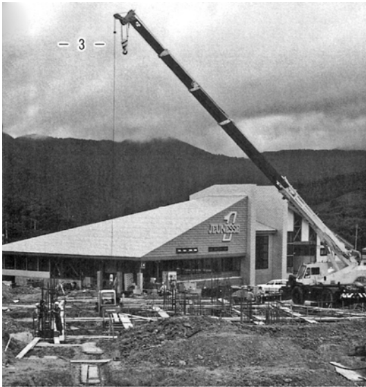
急ピッチで進む建設工事
