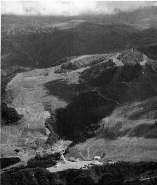
拡張工事中のジュネス栗駒スキー場
