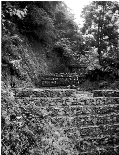
緊急に施行された土止め工事
