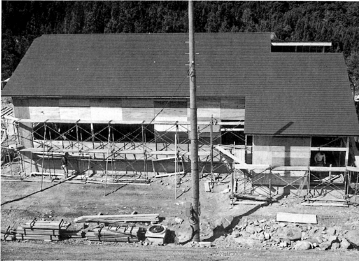
急ピッチで建設中の休養センター
