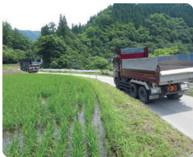
村道不動沢線の拡幅改良
