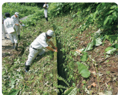
前山取水口から林道入口までの U字溝交換
