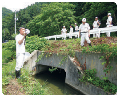
小貫山堰水路の一部改修
