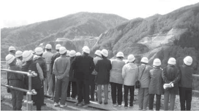
右岸ダムサイトから工事の状況を見学
