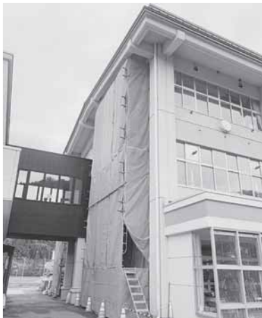
小学校、空調設備（エアコン）工事
