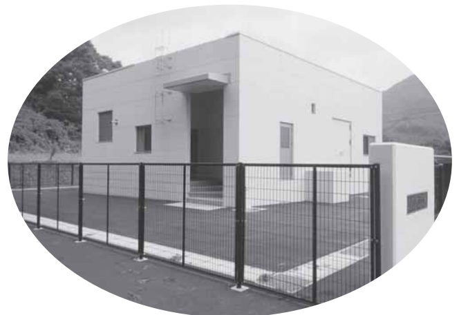
南部地区浄水棟（H29年築）
