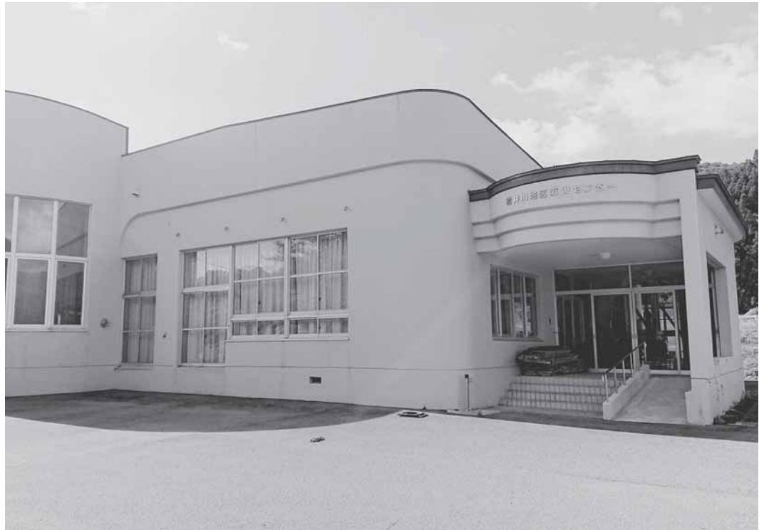
岩井川地区防災センター（備蓄保管庫）
