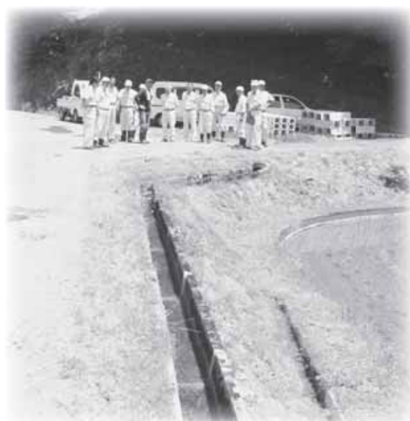
農業用水路の改修（谷地地区）
