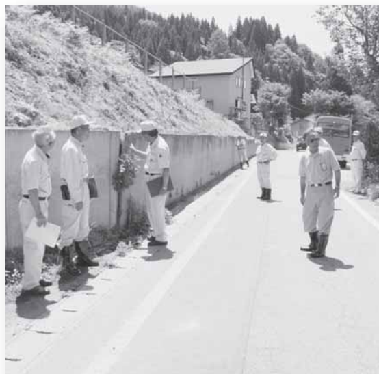
擁壁の補修（手倉地区）
