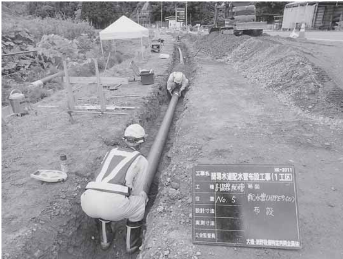
村の簡易水道施設の更新が進められている
