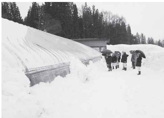
除雪が間に合わずビニールハウスの屋根が変形(間木)
