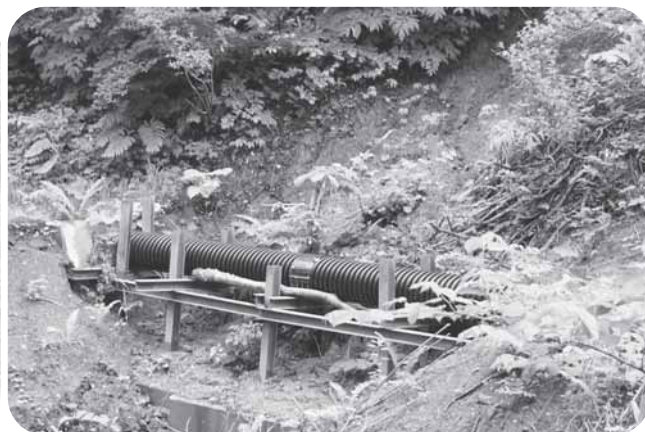
冬期間崩落した水路の復旧（五里台）
