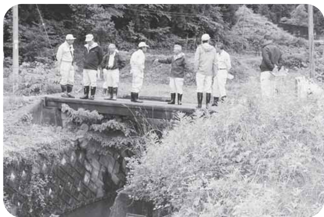
狭くて危険な橋の拡幅（岩井川地区）
