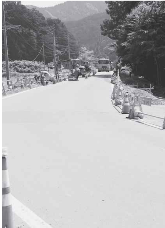
手倉地区国道改良工事（県事業）
