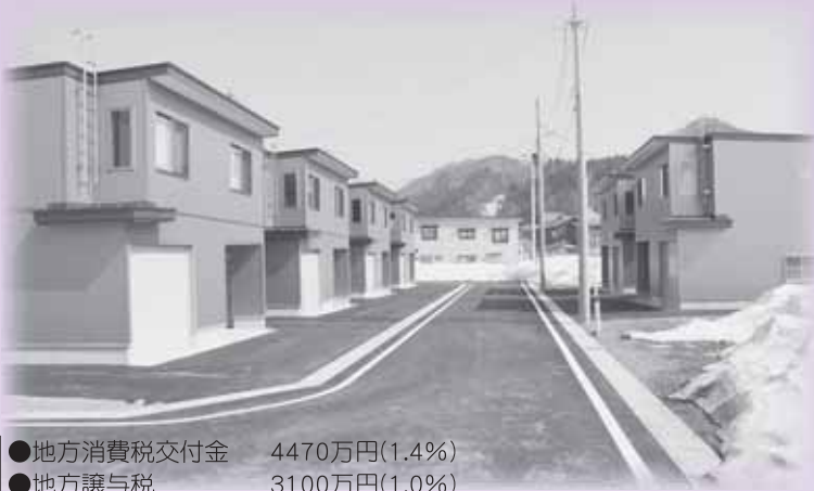
平成29年度完成 田子内定住促進住宅
