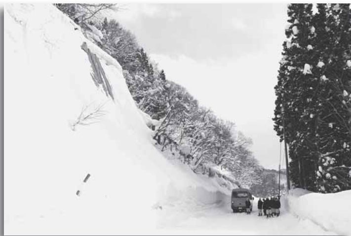
道路への落雪防止対策(滝ノ沢平良線)
