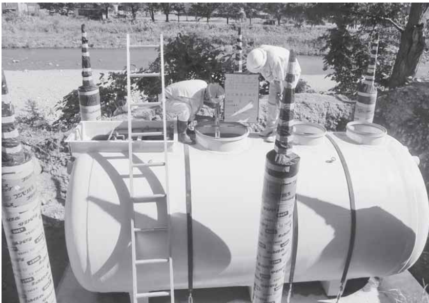
合併処理浄化槽設置工事
