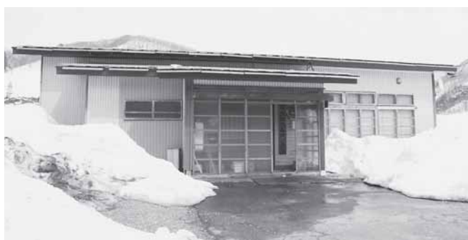
改修が予定されている五里台生活改善センター
