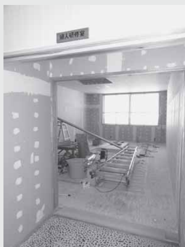
山村開発センター改修の様子
