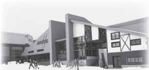
老朽化が進む ジュネスI・ジュネスII
