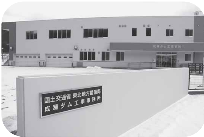
田子内地区に建設された成瀬ダム工事事務所
