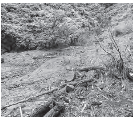
▲岩井川荒沢地区で発生した土砂崩れ
