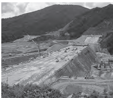
▲工事最盛期を迎えた成瀬ダム
