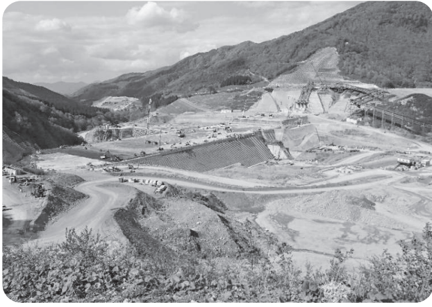
▲原石山展望台から見る建設中の成瀬ダム
