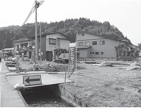
▲田子内地区で整備されている社宅
