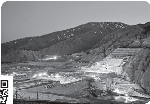
▲右岸展望台から建設中の成瀬ダム (令和5年5月撮影)
