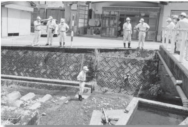
田子内地区(沢方水路取水口改修)
