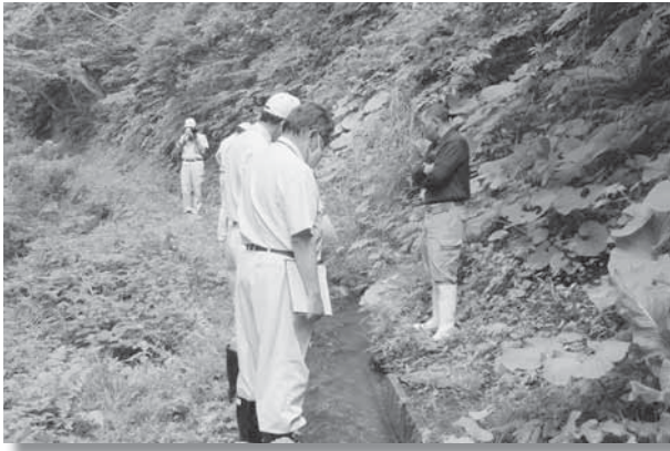
大柳地区(エンマ谷地付近水路側溝撤去再設置)
