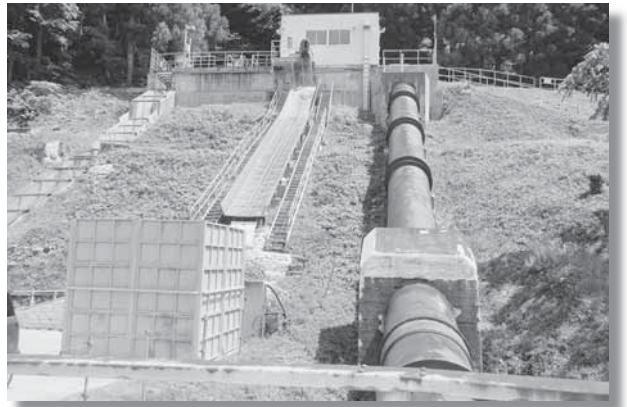
平良地区(発電所内取水口と平良堰の改修)
