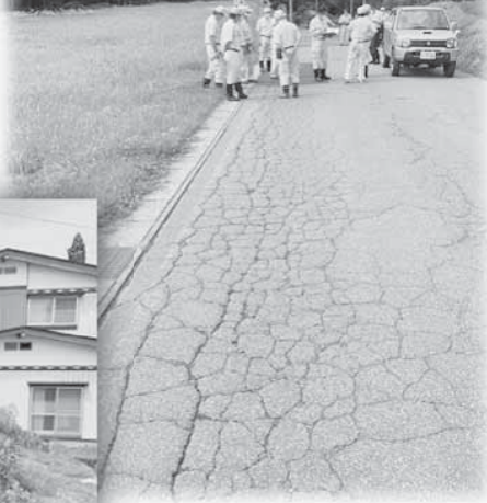
入道地区 横手東成瀬線路面補修
