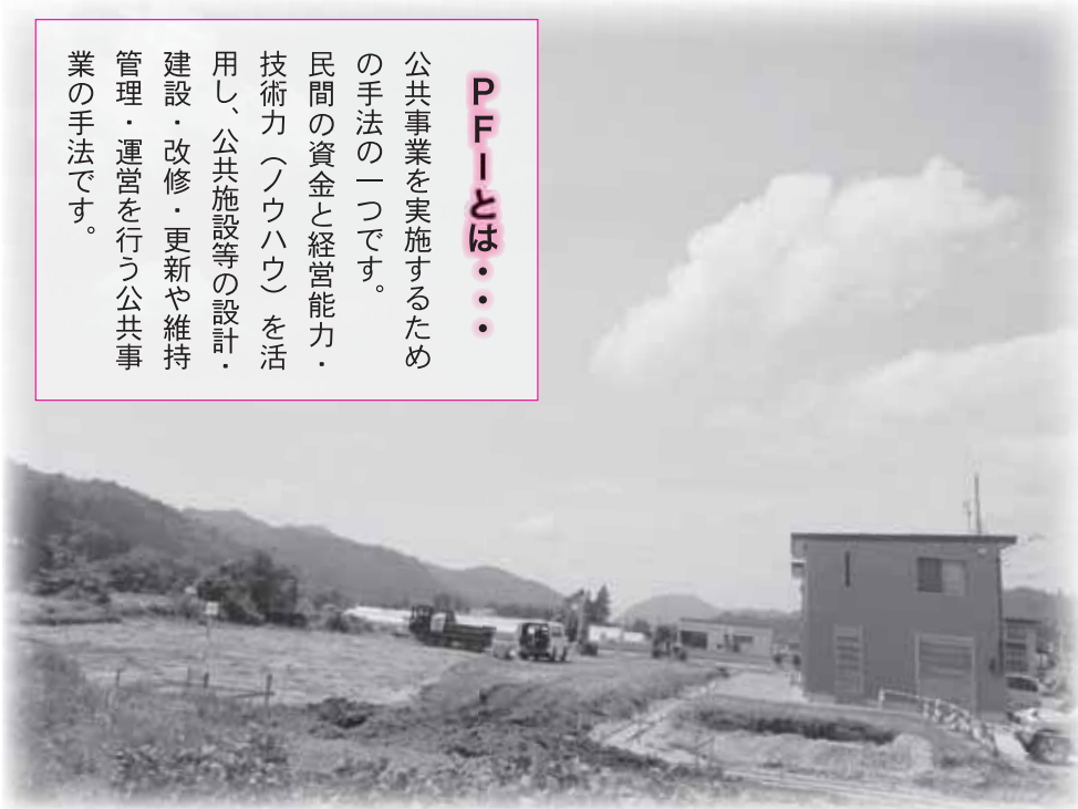
造成が進む田子内の住宅建設予定地
