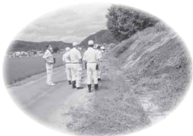
岩井川地区(排水路U字溝の設置)
