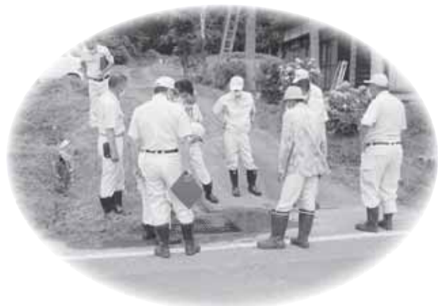
五里台地区(生活用水路の集水柵周辺改修)
