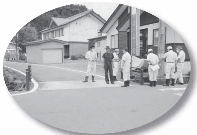
田子内地区(橋の拡幅)
