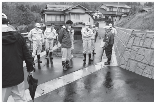
村道橋2号線道路改良工事
