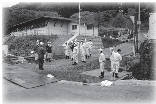
村道宮田上林線道路改良工事
