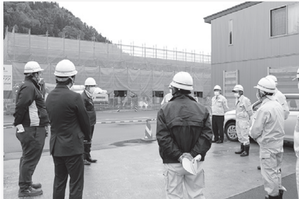
定住促進住宅外構工事
