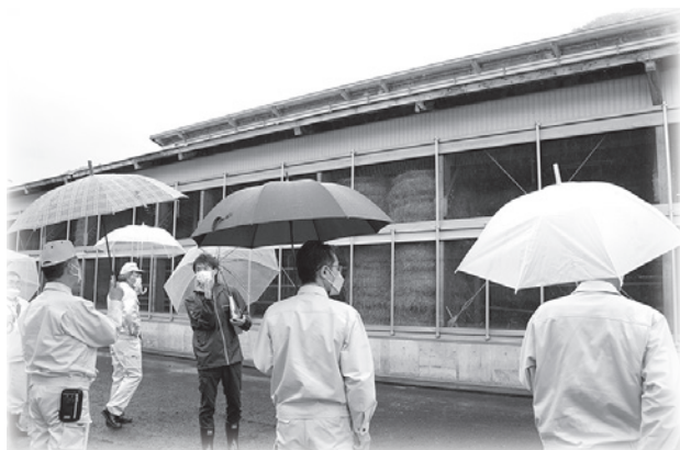
繁殖牛舎雪害修繕工事
