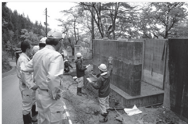
入道配水池築造工事
