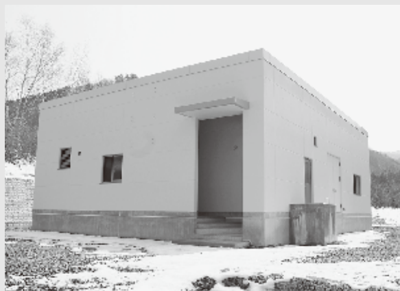
中部地区浄水棟(岩井川字沼又)
