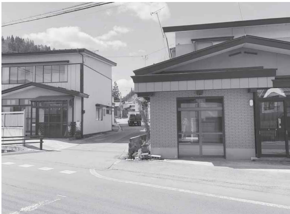
田子内旧国道沢方入口
