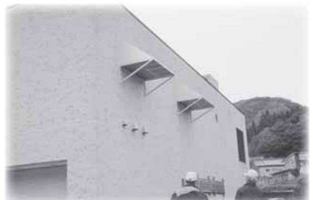
ゆるるん外壁フード修繕工事
