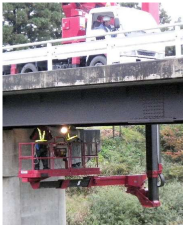
写真3.3 点検車による点検
