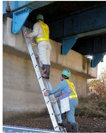
写真3.2 梯子による点検
