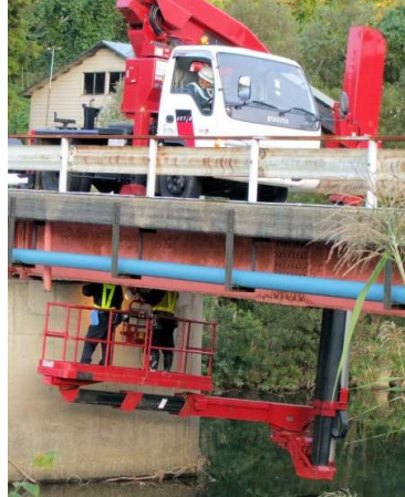
写真3.3 点検車による点検
