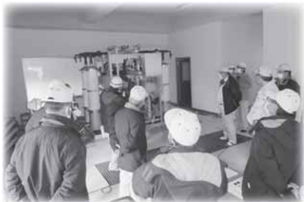
中部地区浄水棟機械設備工事
