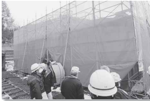
岩井川配水池築造工事
