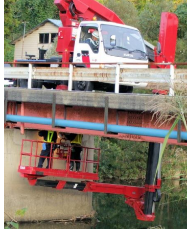
写真3.3 点検車による点検
