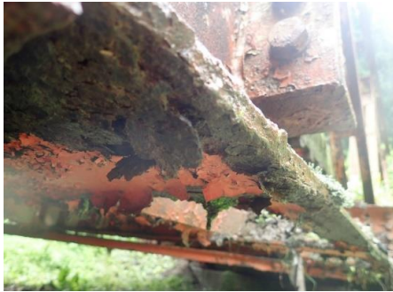
主構トラスの腐食
