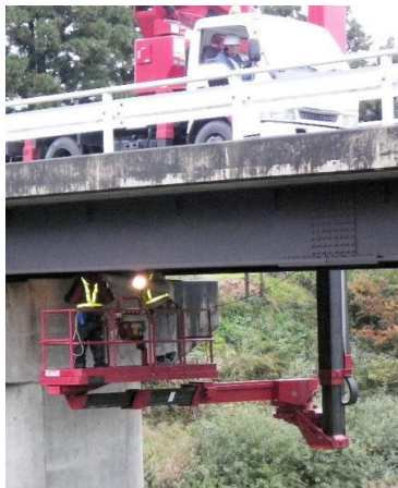
写真3.3 点検車による点検
