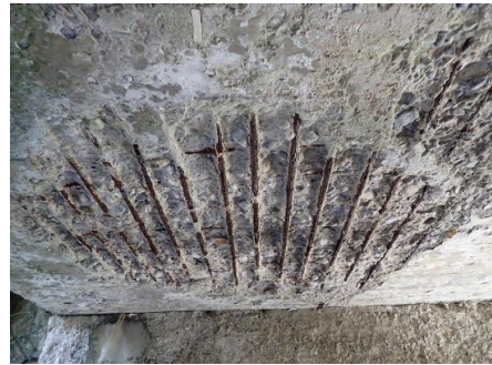
床版の鉄筋露出
