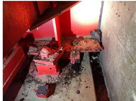
支承（上沓ストッパー部）の破断
