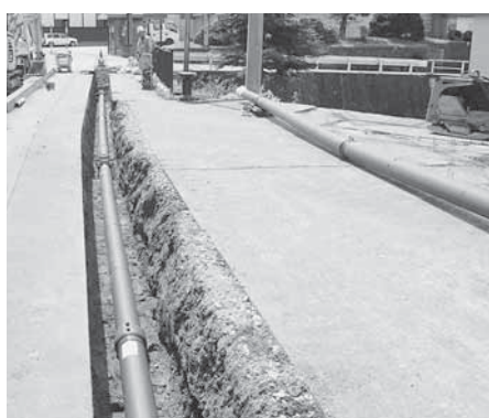
順調に進んでいる水道工事 (岩井川地区)
