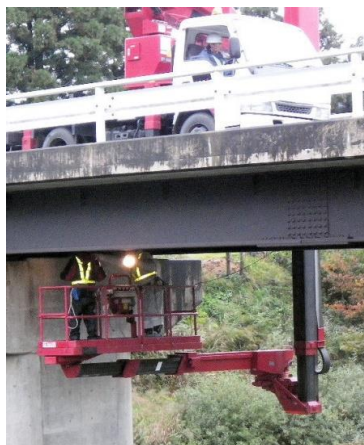
写真3.3 点検車による点検
