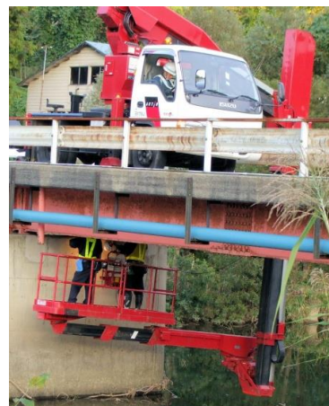
写真3.3 点検車による点検
