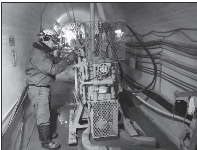
① ボーリング機械による作業状況
