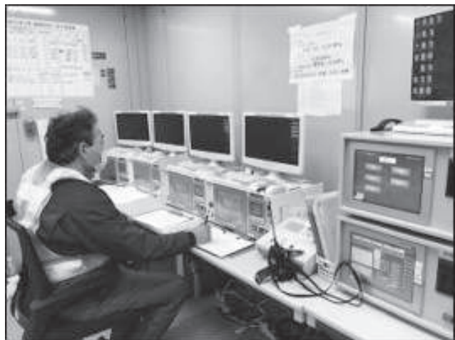
② 注入作業の監視状況(パソコンでの管理)
