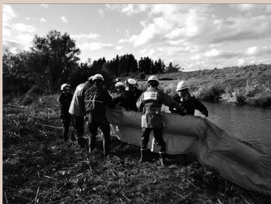
河川にオイルフェンスを設置中
