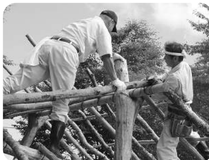
屋根骨組作業
