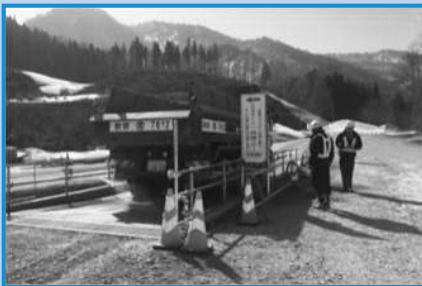
現場内から出る車両は、 高圧水洗浄設備によって 泥を落とします。
