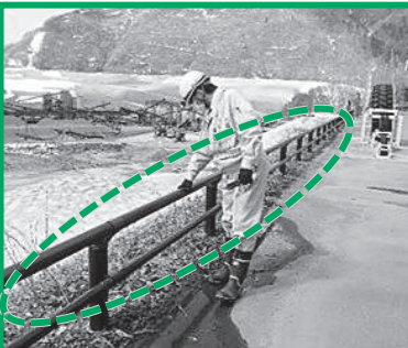
↑防護柵の損傷の有無を確認
