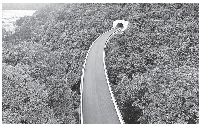
▲橋面塗装が進む2号橋
