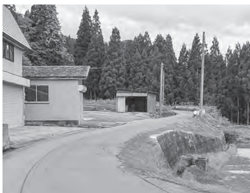
▲ガードレール設置要望箇所
