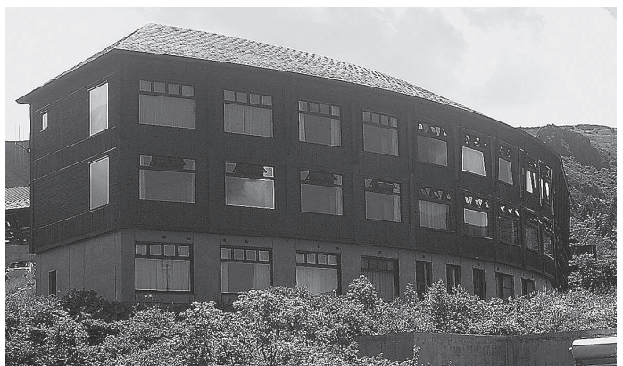
窓サッシを改修した栗駒山荘
