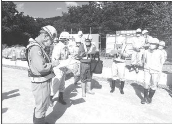
④点検後の打合せ(原石山採取工事)
