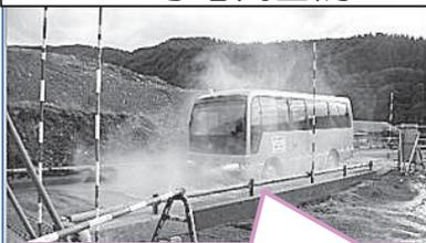
現場内から出る車両は、高圧水洗浄設備によって泥を落とします！
