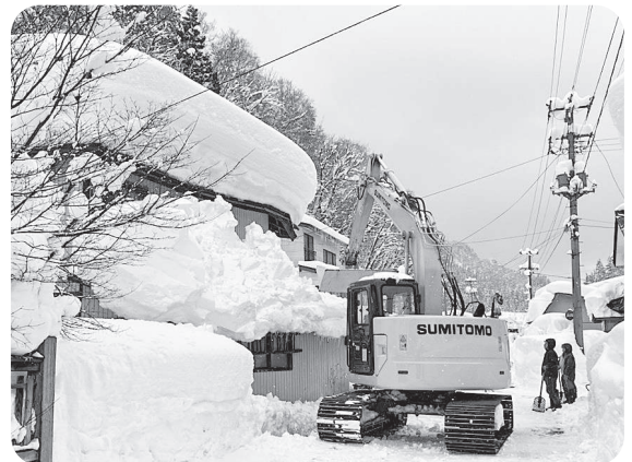
▲空き家の雪庇落とし
