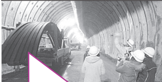
こちらが鋼製支保工で使用するアーチ型の鋼材。この鋼材を設置した後、「弁慶」というトンネル工事専用重機でコンクリートを吹き付けて固めていきます。
