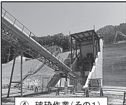
④ 破砕作業(その1)
