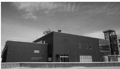
南側から見た新消防庁舎
