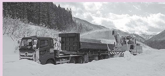
26tダンプトラックへの積込状況
