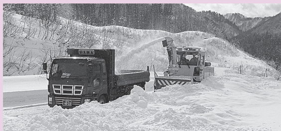
10tダンプトラックへの積込状況
