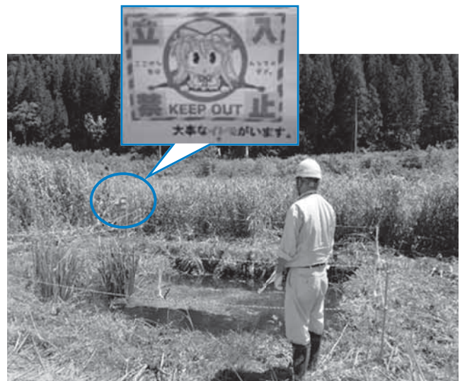
移植前は工事でイトモを傷つけないように、トラロープで目印を付けています。(桧山台地区)
