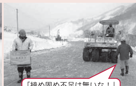
「締め固め不足は無いな！」
