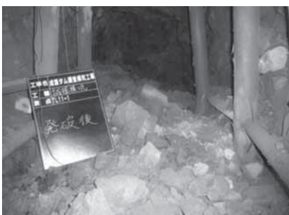
火薬を使って岩盤を崩した後
