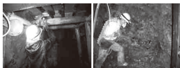
調査横坑工事施工状況
