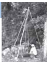
ボーリング作業状況
