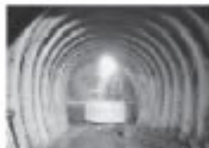
下段トンネル貫通時の状況
