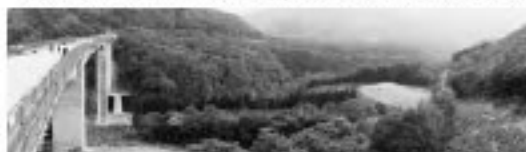
■1号橋 側方より
