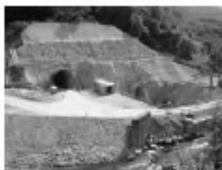
■転流工各口 全景
