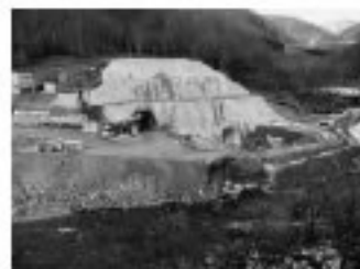
■転流工施行状況
