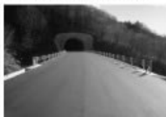
■ 国道改良部 1号トンネル付近(H22.12)
