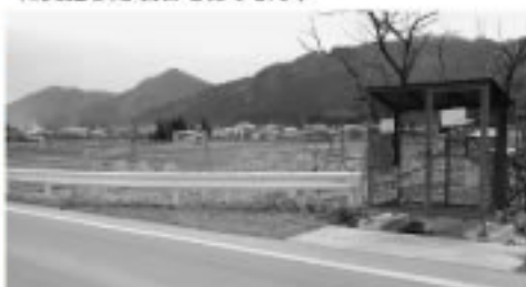
■ガードレール設置(滝ノ沢地区)
