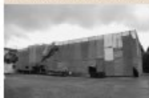
10/5 成瀬川交流館改修工事
