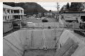
10/12 合併処理浄化槽設置工事(3工区)
