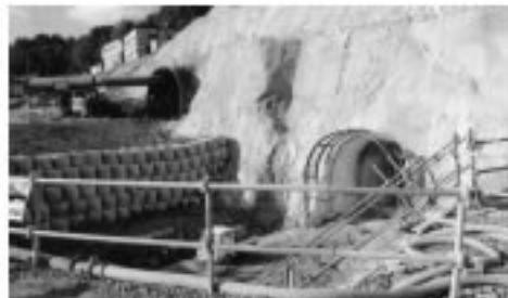
■ 国道付替1号橋工事の現場・転流工工事(呑口)の現場
